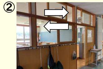
廊下の窓からCO2が外へ
